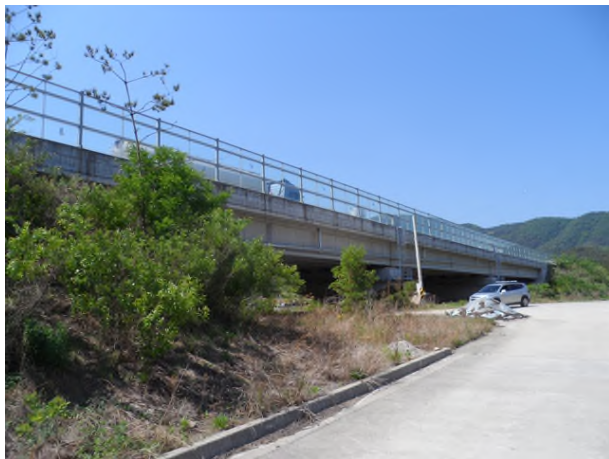
7공구 배골교 (7공구)
