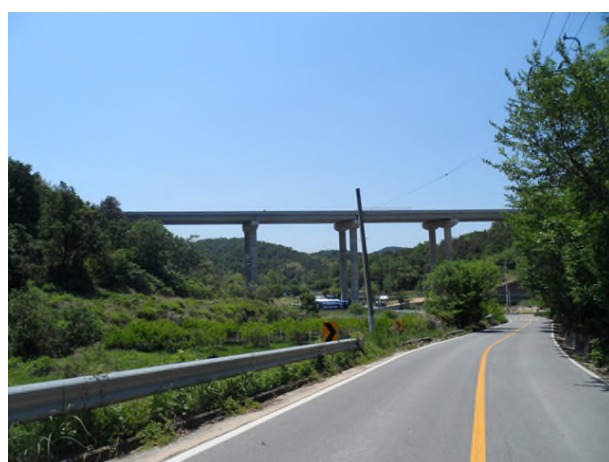
5공구 오실교 (5공구)
