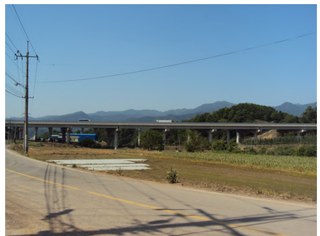
8공구 가천교 (8공구)
