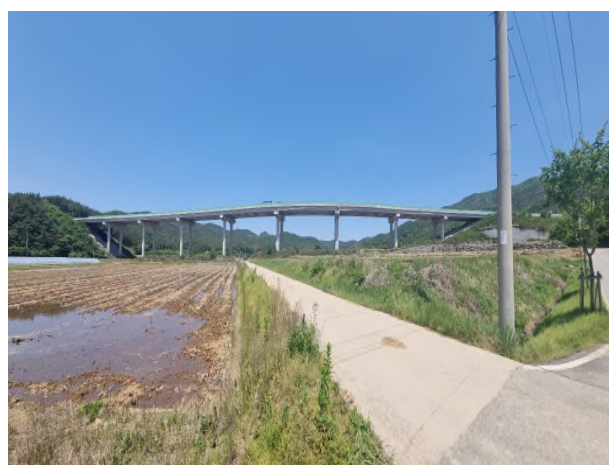
3공구 도개교 (3공구)
