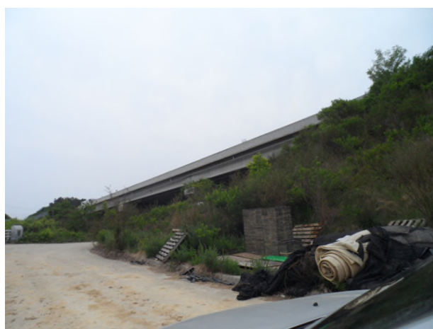
2공구 월가교 (2공구)
