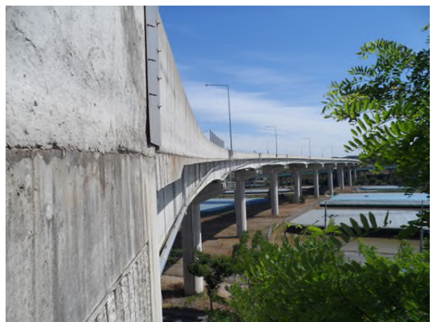
10공구 영천JCT Ramp-B교(10공구)
