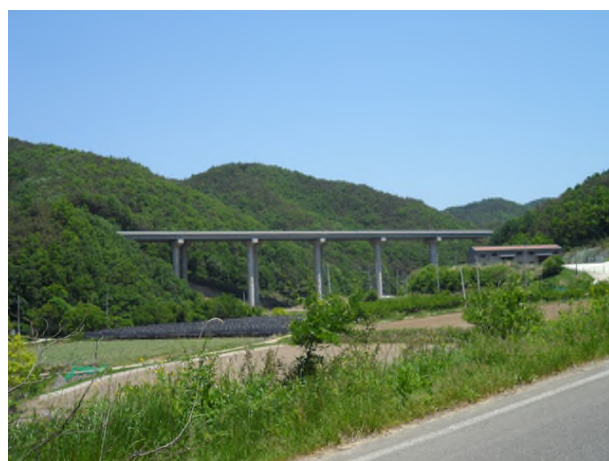
4공구 산호교 (4공구)
