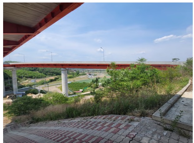
8공구 화산JCT RAMP-H교(8공구)
