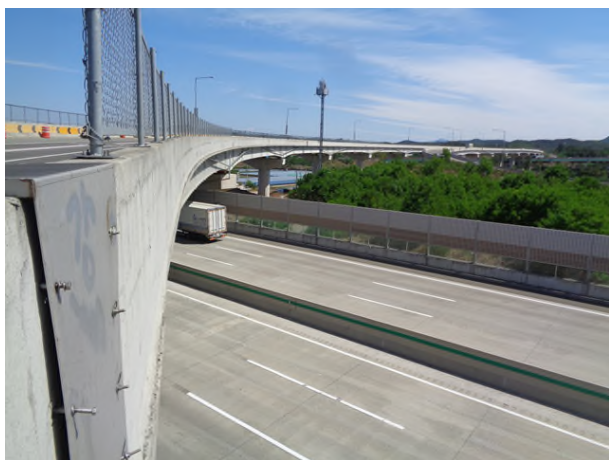
10공구 영천JCT Ramp-A교(10공구)
