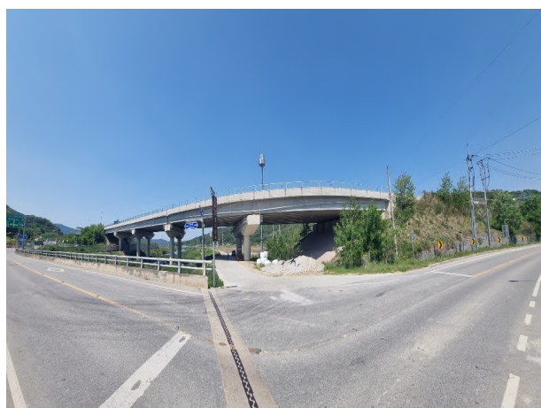
3공구 신계교 (3공구)
