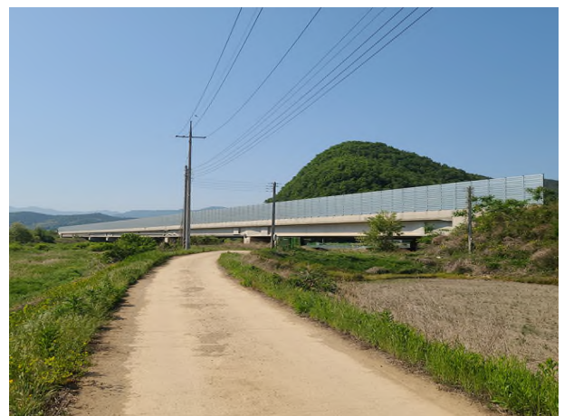
6공구 금매교 (6공구)
