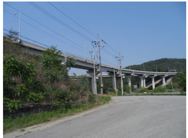
5공구 군위JCT R-C교(5공구)
