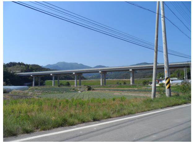
7공구 산성교 (7공구)
