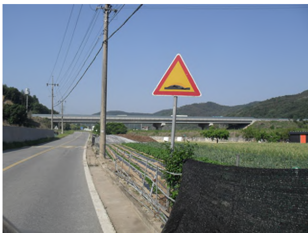
6공구 창기교 (6공구)
