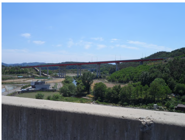
8공구 화산JCT RAMP-A1교(8공구)
