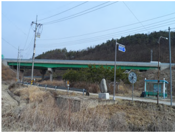
6공구 가호교 (6공구)
