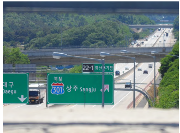
8공구 화산JCT RAMP-A교(8공구)
