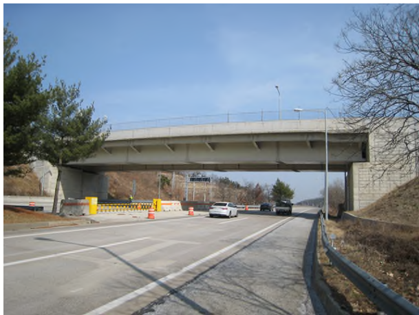
5공구 군위JCT R-A4교(5공구)
