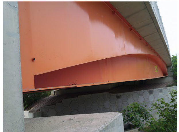
7공구 화남1교 (7공구)
