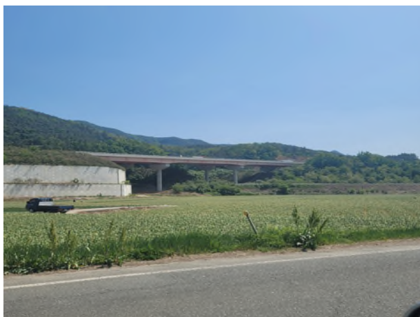
7공구 화남교 (7공구)
